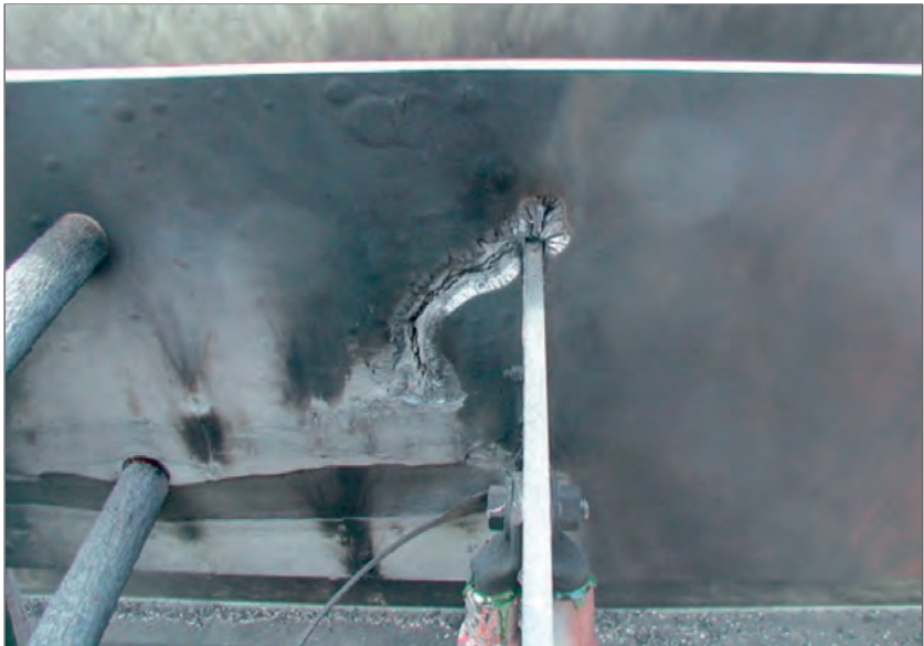
Bild 1.3 Teilentladungskanal in einer Isolierstoffplatte mit anschließendem Kurzschluss
