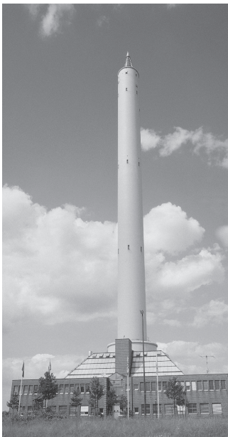
Bild 2.14: Fallturm in Bremen für Untersuchungen unter Mikrogravitation
