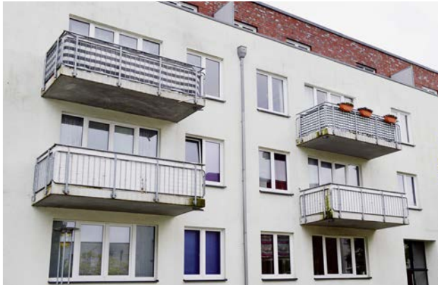
Abb. 1.5: Fassade mit auskragenden Balkonen aus Stahlbetonplatten
