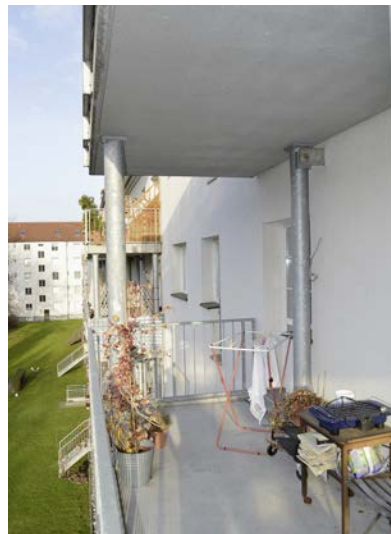
Abb. 1.7: Seitenansicht einer nachträglich vorgelagerten Stützenkonstruktion: Die Konstruktion wurde unterhalb der Betonplatte zur horizontalen Aussteifung am Gebäude befestigt.
