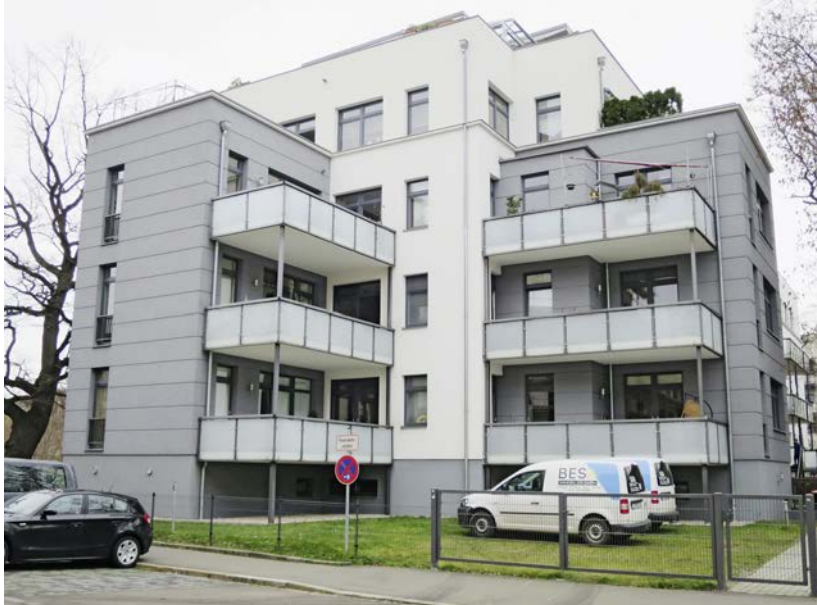
Abb. 1.3: Gebäude mit vorgelagerten Balkonen vom Erdgeschoss bis zum zweiten Obergeschoss und Dachterrassen in den oberen Geschossen
