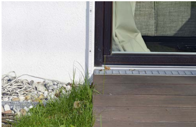
Abb. 1.12: Detailansicht eines Terrassen- anschlusses an das angren- zende Fenster- element
