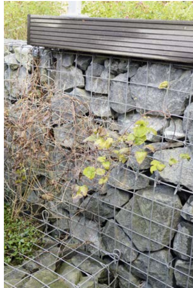
Abb. 1.14: Gabionenwand zur Sicherung einer Terrassenböschung
