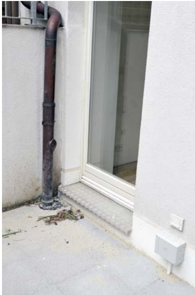
Abb. 1.13: Terrasse eines Souterrains nach einer Instandsetzung der Abdichtung des Sockels und der Installation einer Pumpenanlage für die Entwässerung
