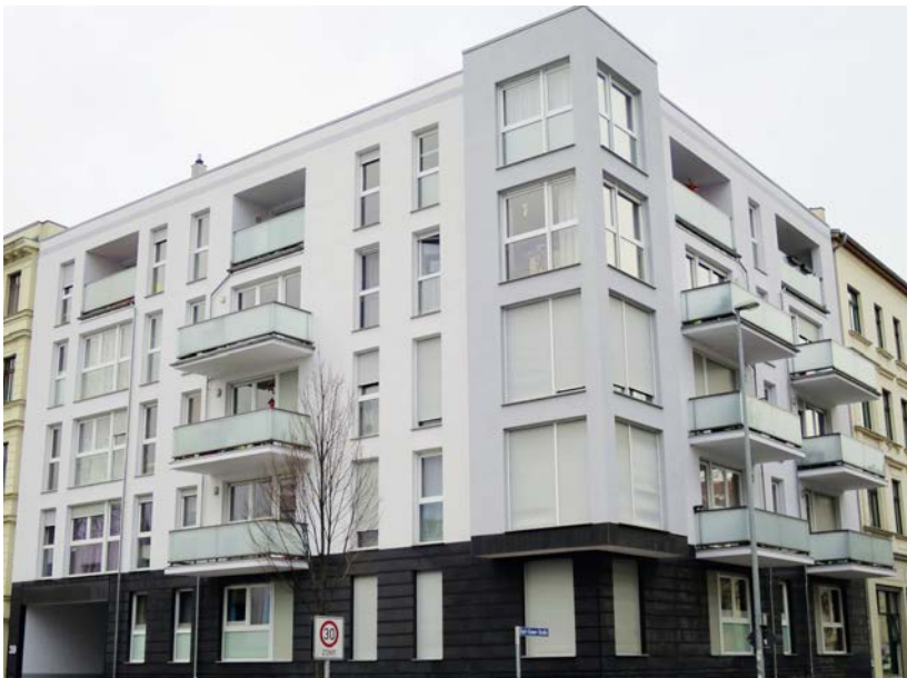
Abb. 1.2: Gebäude mit auskragenden Balkonen vom ersten bis zum dritten Obergeschoss und Loggien im obersten Geschoss
