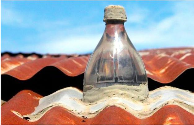
*Abbildung 2: Die Funktionsweise der Liter Licht Lampe
